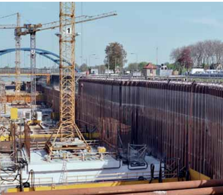
Ingenieurwissenschaftlicher und juristischer Sachverstand sind gefordert, wenn Bauprojekte wie die Erneuerung der Schleuse Sülfeld bei Wolfsburg durchgeführt werden.
