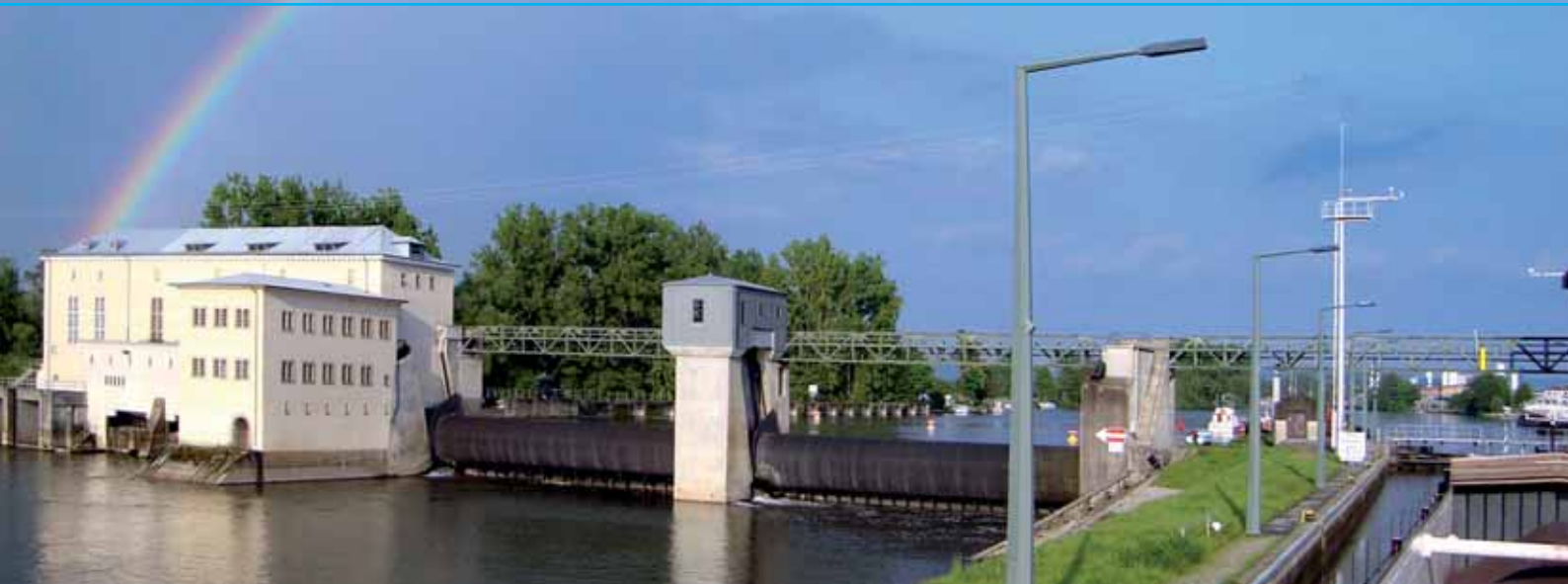
Schleuse Garstadt (Main)
